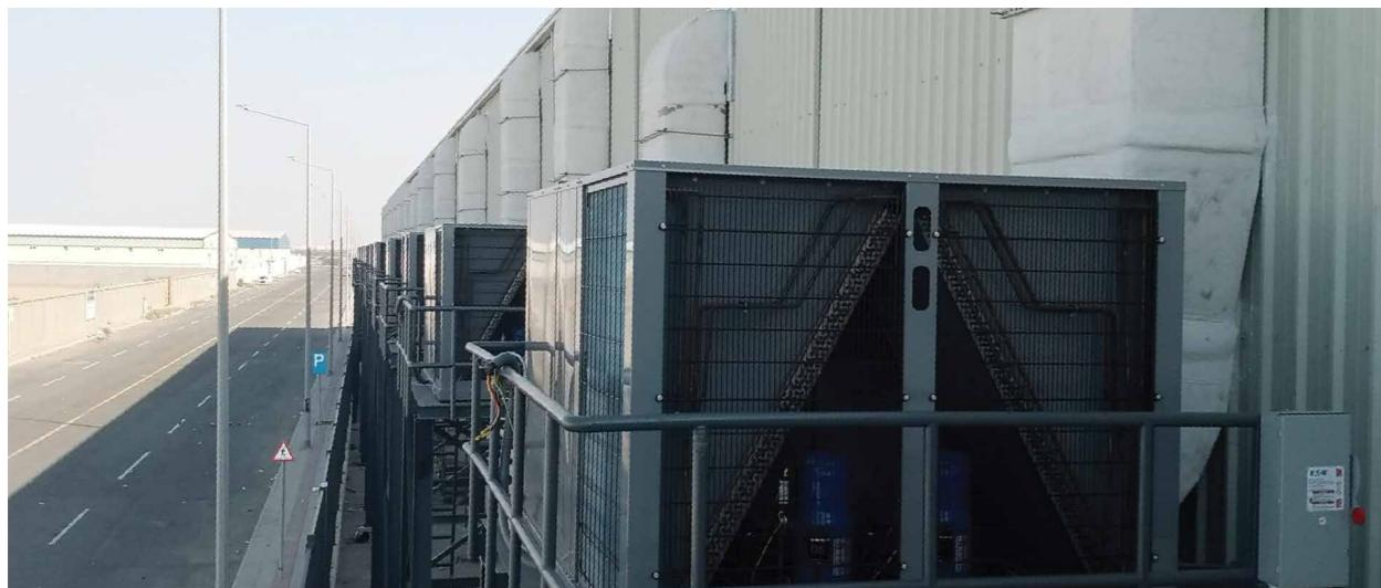
وقد تضمن المشروع توريد وتركيب ٢٢ وحدة تكييف عالية القدرة لضمان ثبات درجات الحرارة وفق المعايير المطلوبة، إضافة إلى تصنيع وتركيب منصات فولاذية مخصصة لتحمل أوزان أجهزة التكييف الثقيلة. كما تم تنفيذ نظام مجاري هواء ليفية (Fiber Ducting) يضمن توزيعاً متوازناً للهواء داخل المنشأة لتحقيق أعلى كفاءة تشغيلية.
